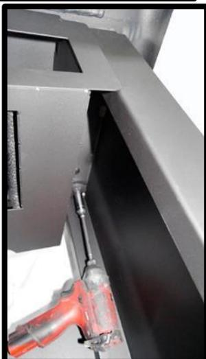
10. Installer le renfort derrière le piédestal et remettre le poêle debout sur le piédestal.
